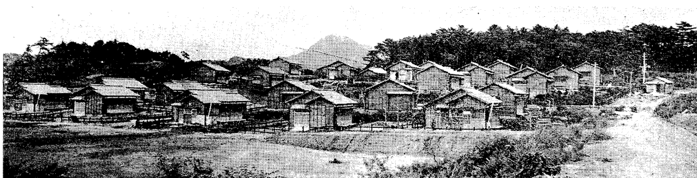
図 7 県営住宅が建ち並ぶ様子 33
